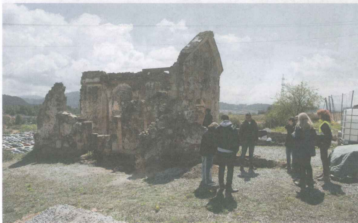
Ermita de Sant Joan de Benviure, el año pasado, tras las obras de consolidación de la estructura. ALEX MATEU
