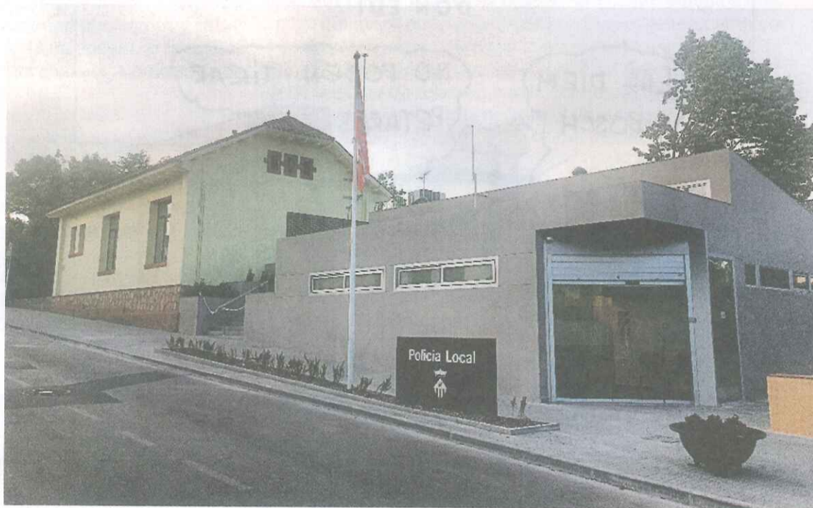
Las dependencias de la Policía Local, tras las obras de ampliación y mejora. COMUNICACIÓ MATADEPERA
