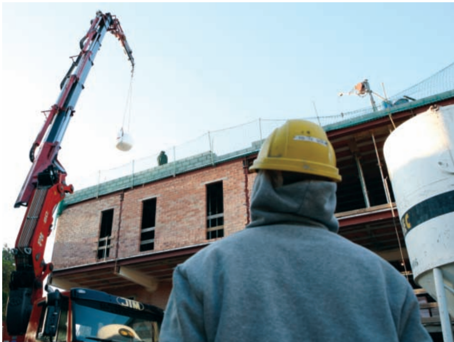
Les obres del nou Centre d'Atenció Primària avancen a molt bon ritme i l'equipament s'inaugurarà el març del 2009
