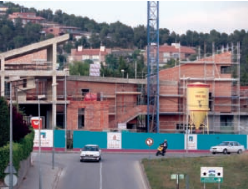
Les obres de construcció dels pisos han avançat força en els darrers mesos
