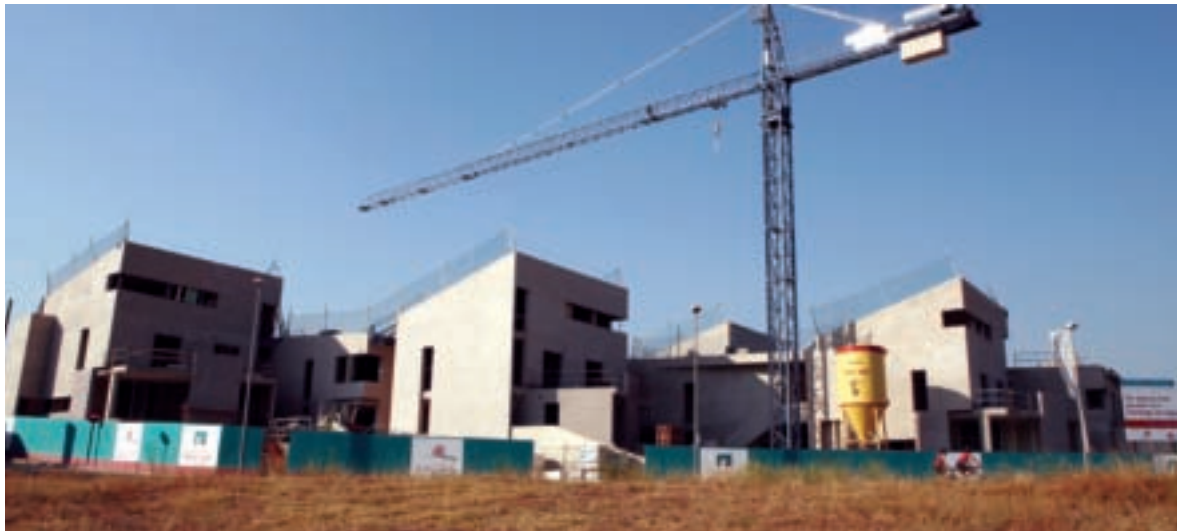
Continua la construcció dels primers 36 habitatges, encara que amb cert retard
