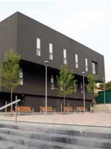
Vista de la façana del nou CAP
