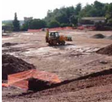
Vista de les obres a finals de setembre
