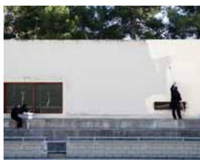
Treballs de pintura a les piscines ©GM
