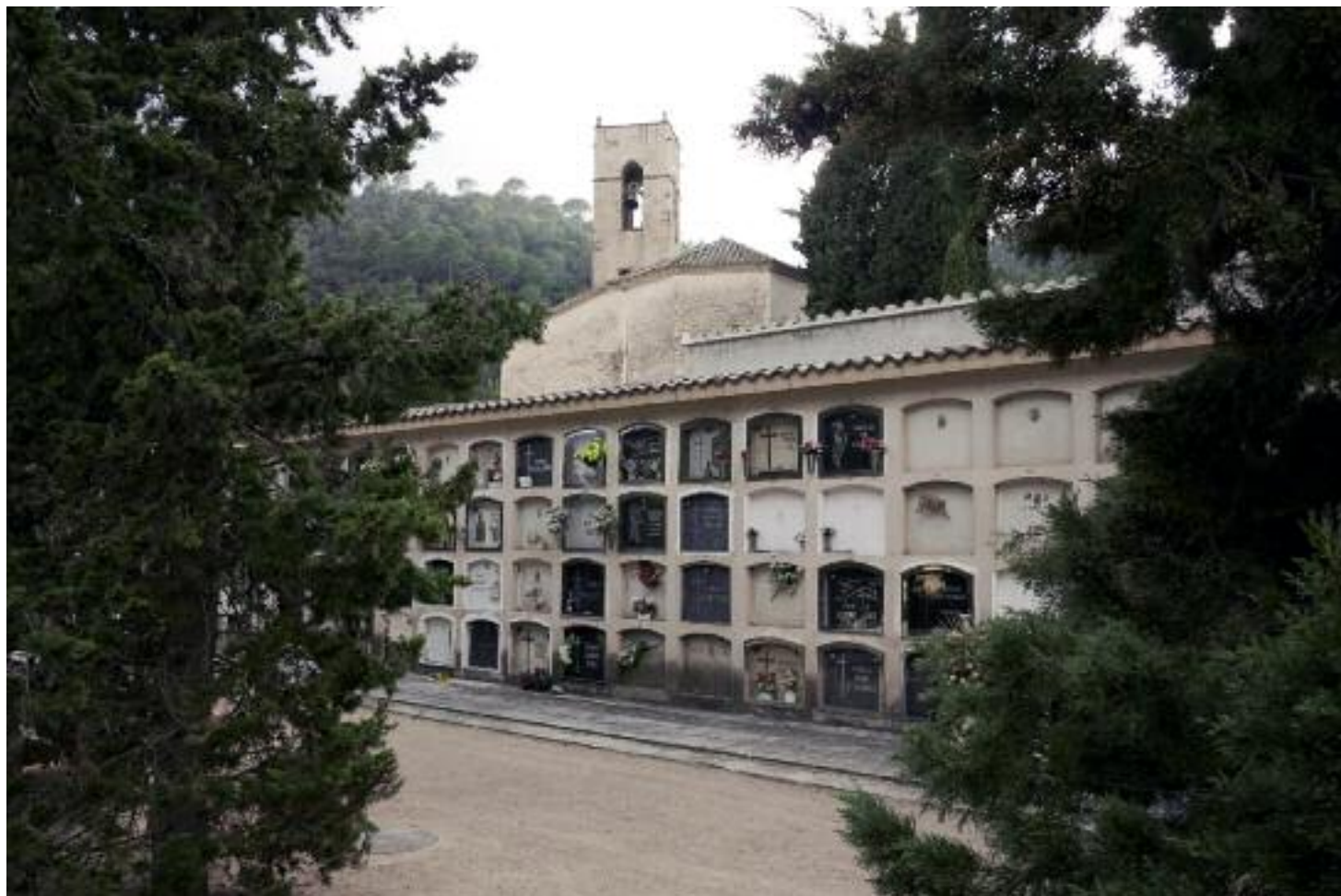
Una de les obres més importants i urgents que s'han de fer a Matadepera és l'ampliació del Cementiri de Can Roure. Ara es crearà un nou mòdul amb 16 nínxols nous
