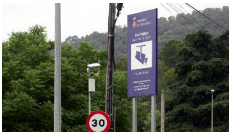
Una de les càmeres que s'han instal·lat a diversos punts de Matadepera i que contribueixen a millorar la seguretat ©GM
