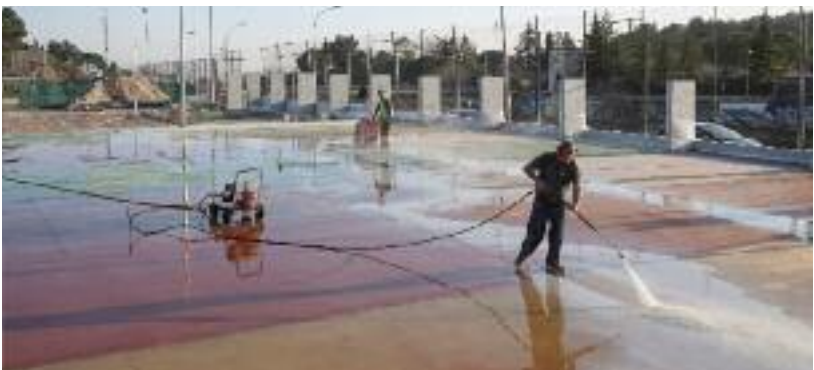
Els tècnics ultimen els darrers detalls de la nova pista poliesportiva del municipi. ©Miquel Badia
