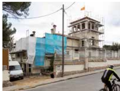
La Torre Ballbè-Molins en obres. ©Miquel Badia
