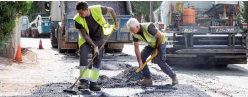
Dos treballadors asfalten a l'estiu un carrer del municipi. ©Miquel Badia
