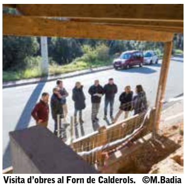
Visita d'obres al Forn de Calderols. ©M.Badia
